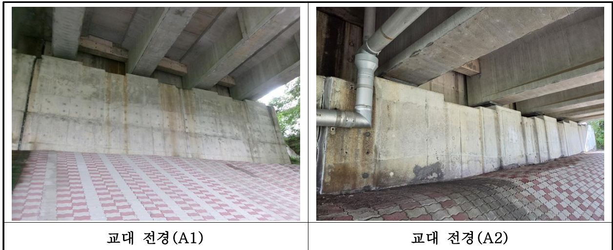
【사진 14.3.33】 교대 전경
