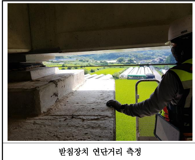
【사진 14.3.40】 교량받침장치 연단거리측정
