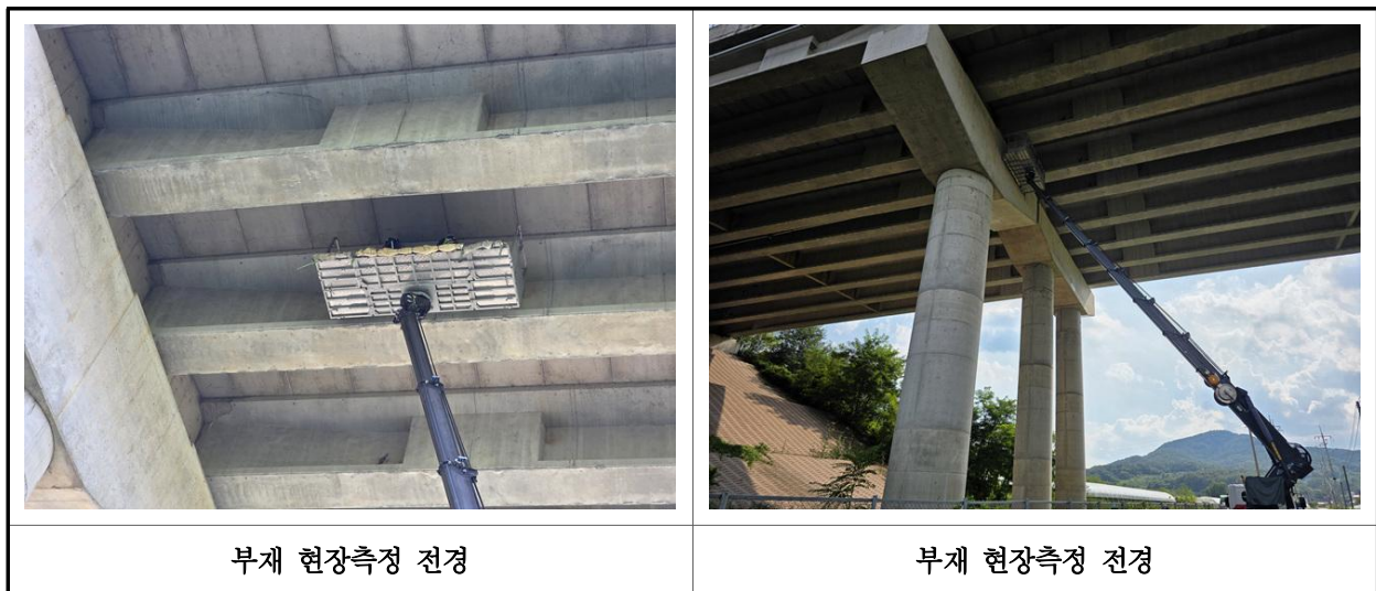
【사진 14.2.1】 부재 현장측정 전경
