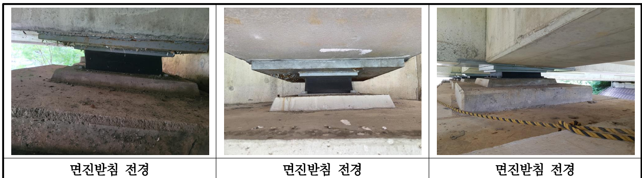
【사진 14.3.38】 교량받침 전경
