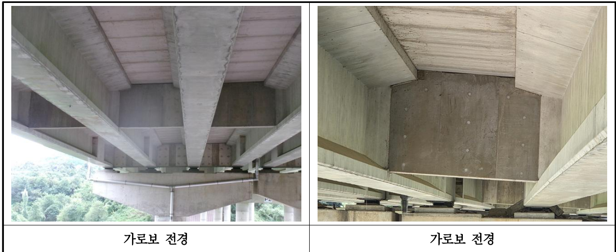
【사진 14.3.6】 가로보 전경
