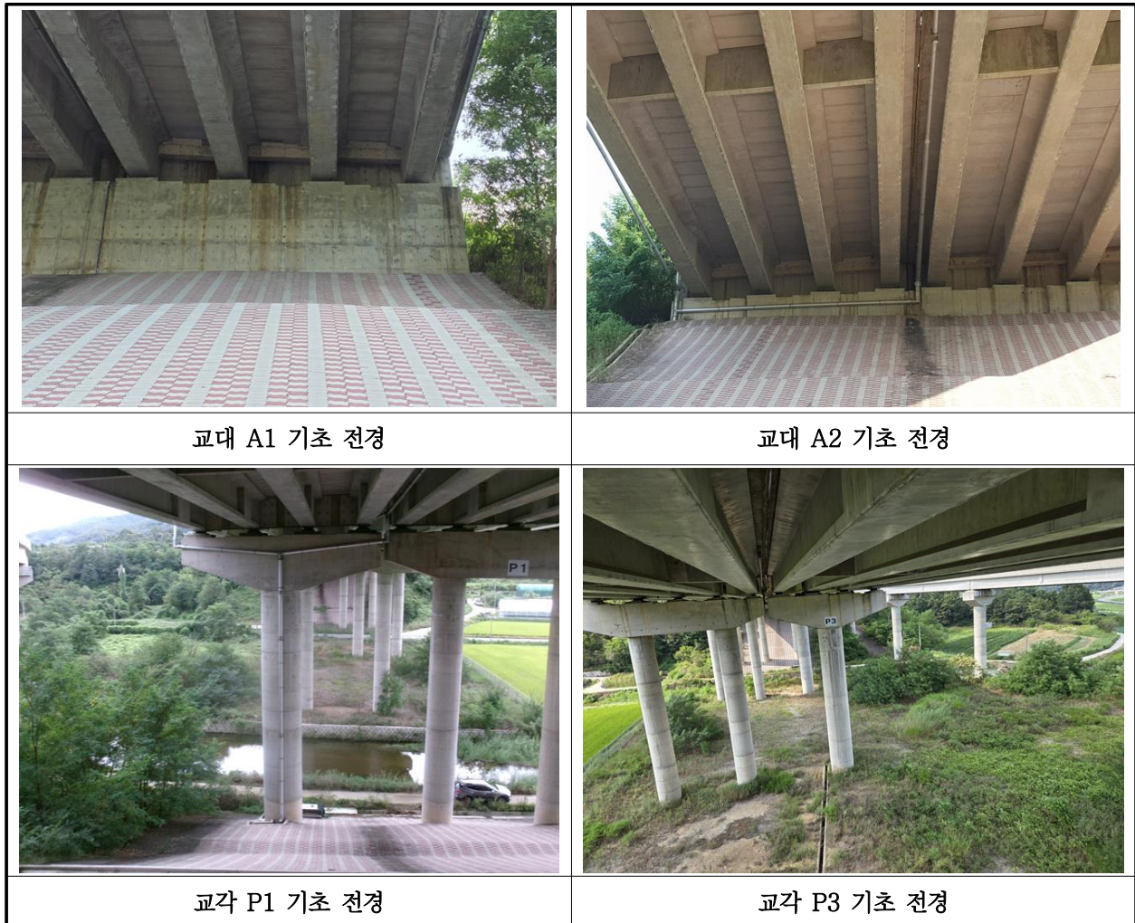
【사진 14.3.12】 기초 전경
