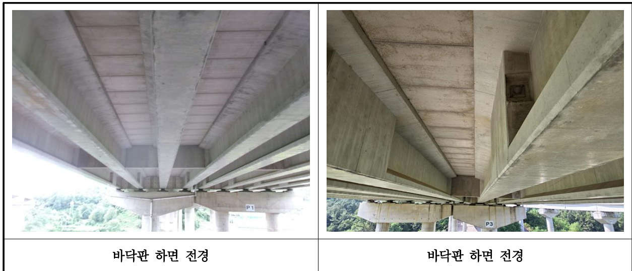
【사진 14.3.2】 바닥판하면 전경
