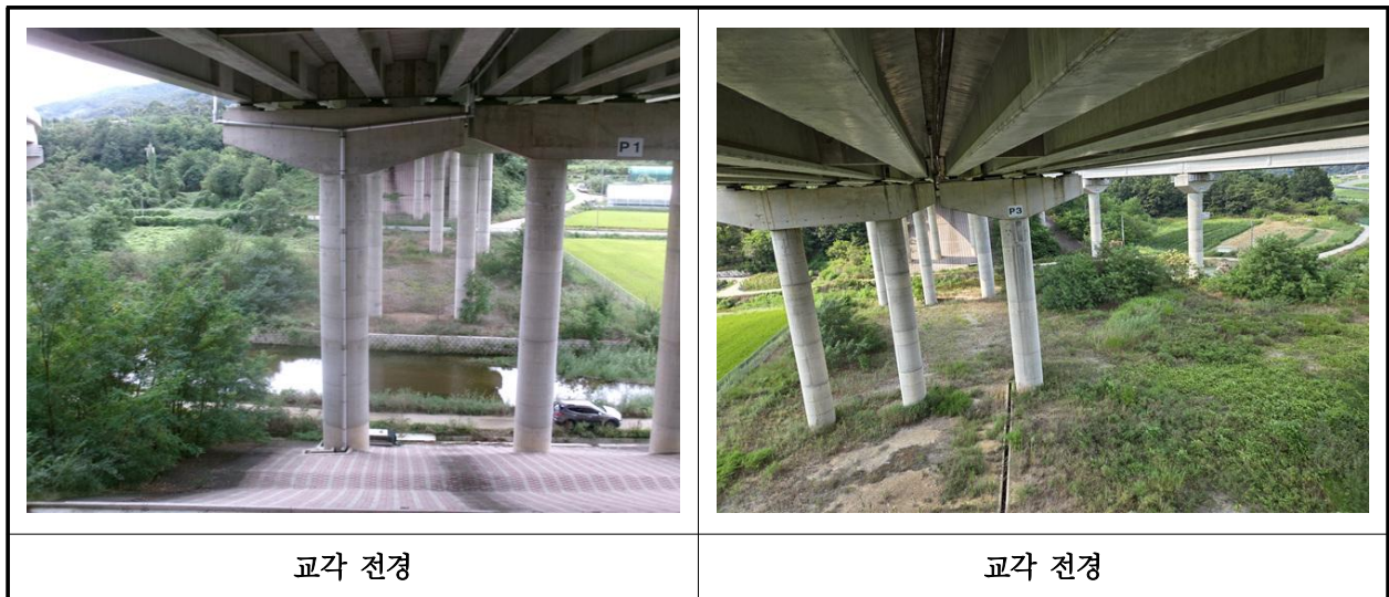
【사진 14.3.10】 교각 전경
