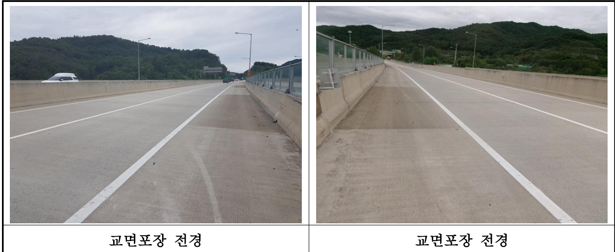
【사진 14.3.20】 교면포장 전경
