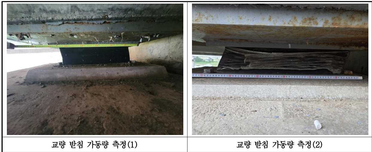
【사진 14.3.41】 교량받침 이동량 측정
