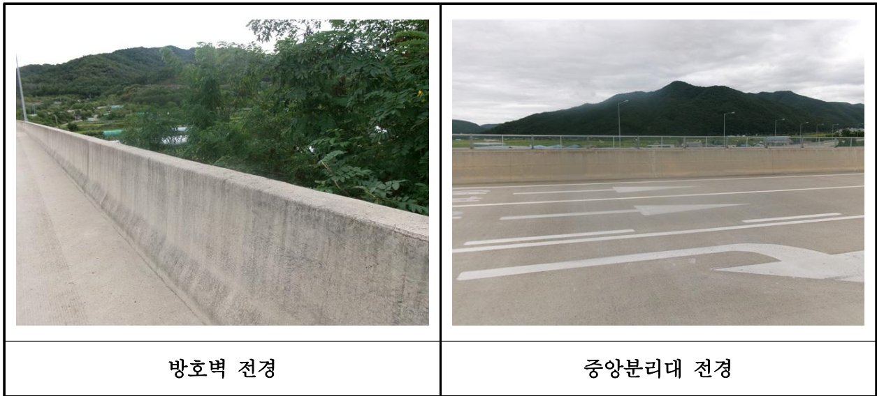
【사진 14.3.49】 방호벽 및 중앙분리대 전경
