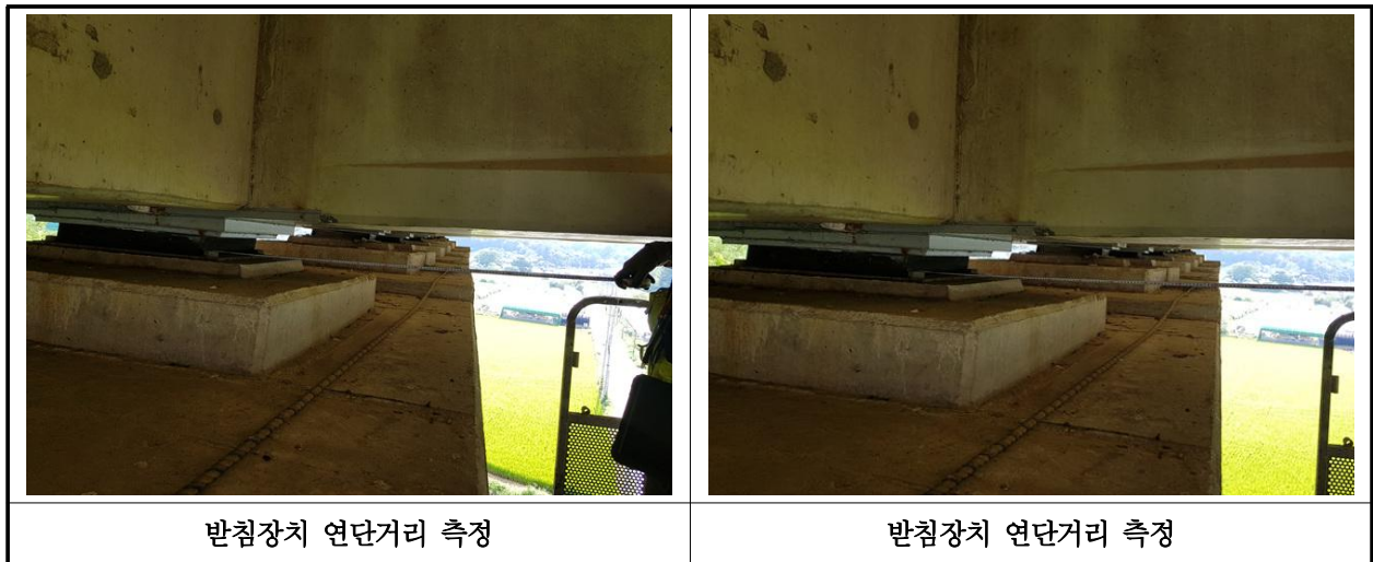
【사진 14.3.15】 교량받침장치 연단거리측정
