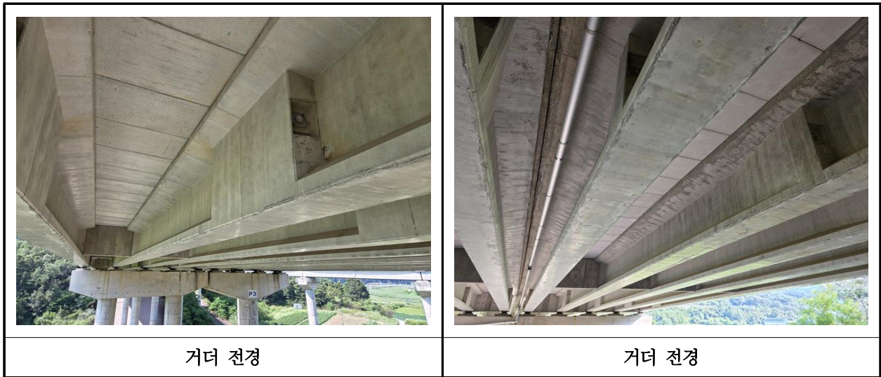
【사진 14.3.29】 거더 전경
