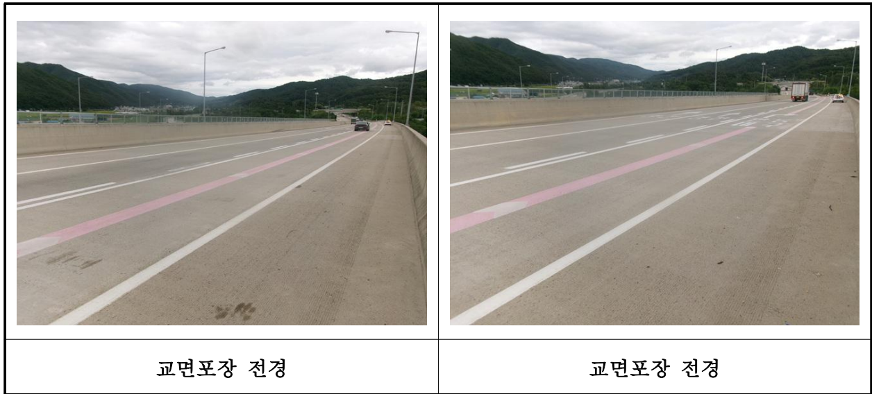
【사진 14.3.45】 교면포장 전경
