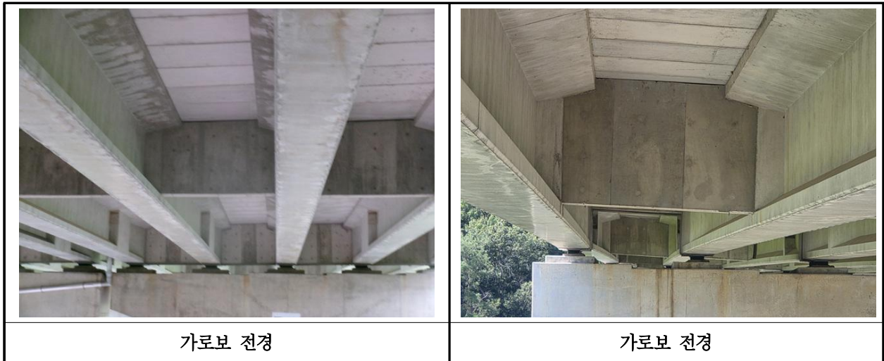
【사진 14.3.31】 가로보 전경
